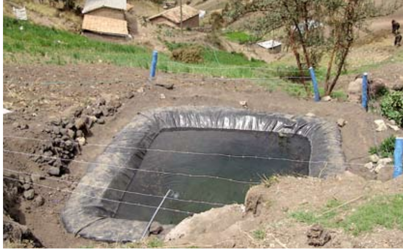
Reservorio con geomembrana
